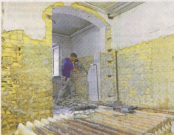
Micha Kieneck bei Entkernungsarbeiten in der Villa.
