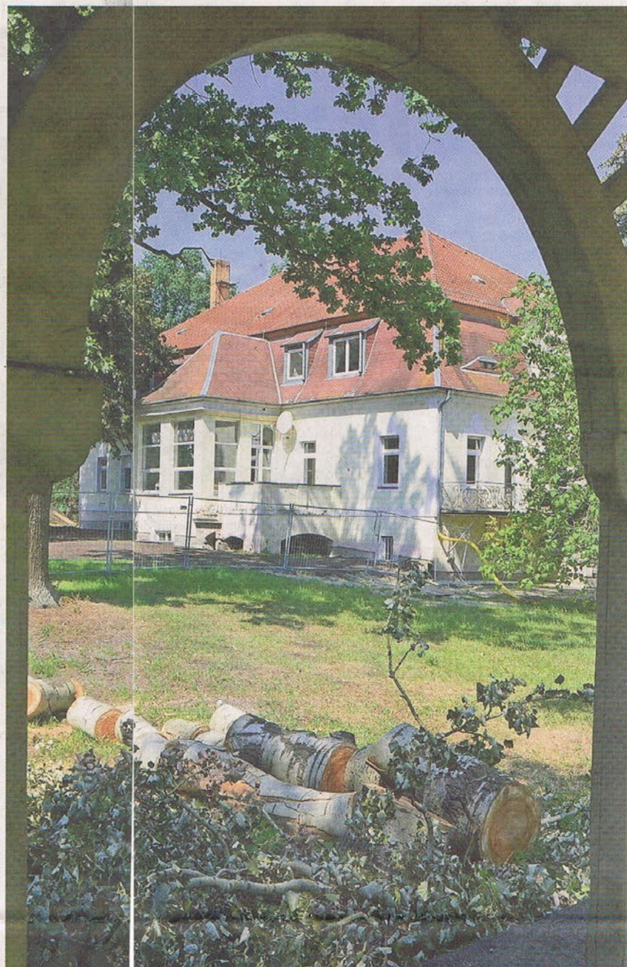
Aus der Direktoren-Villa mit langer Geschichte wird jetzt eine Jugendherberge. In dem Haus war später eine Geburtsklinik unterbracht. Zuletzt war es als Psychiatrie genutzt worden.
